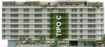
UBICACIÓN EN FACHADA
